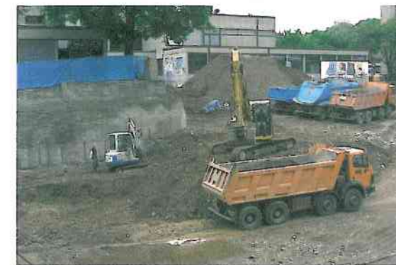
Allgemeine Zufriedenheit herrschte beim Spatenstich für die Sporthalle mit OB Dr. Dieter Salomon im März. Mittlerweile ist die Tiefgarage abgerissen. Die Erdarbeiten für die Sporthalle haben begonnen.
